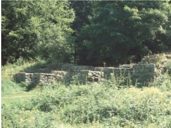
Eine der teilweise wiederaufgemauerten Toranlagen des Feldbergkastells.
