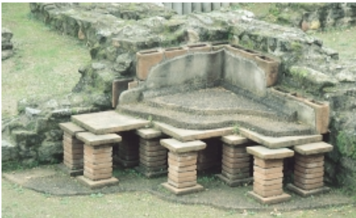
Blick auf eine Teilrekonstruktion des beheizten Fußbodens.
