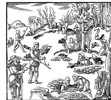
Holzschnitt von 1556 mit Bergwerksbetrieb mit flachen Schürfschächten.
