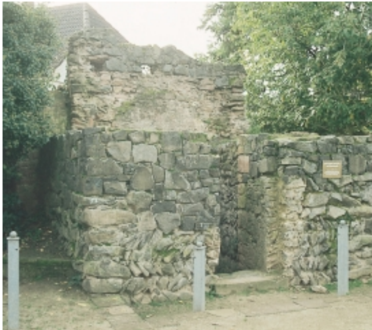
Der im Mittelalter erneuerte Turm.
