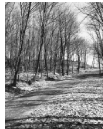
Blick von Westen auf die „Rödchesmauer“.
